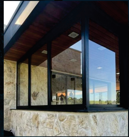
JANELAS DE ESQUADRIAS DE ALUMÍNIO
